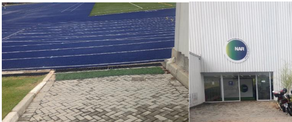
Figura 7 – Rampas de acesso.
