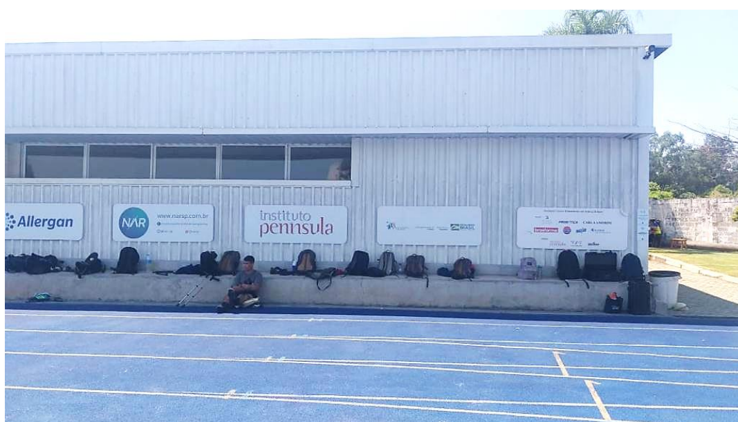
Figura 95- Placas da Lei de incentivo na Estrutura do NAR-SP (4)
